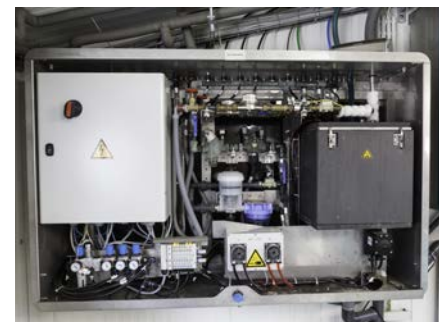
Die Versorgungseinheit mit: Reinigung, Peressigsäure- und Dippmitteldosierung, Druckluftverteilung und elektrischer Steuerung.
