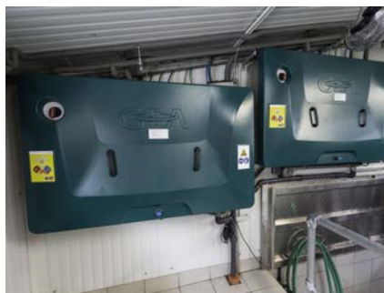
Bis Mitte 2017 stattete Gea jede Monobox mit einer Versorgungseinheit aus. In Zukunft genügt eine „Greenbox“ für drei Monoboxen.
